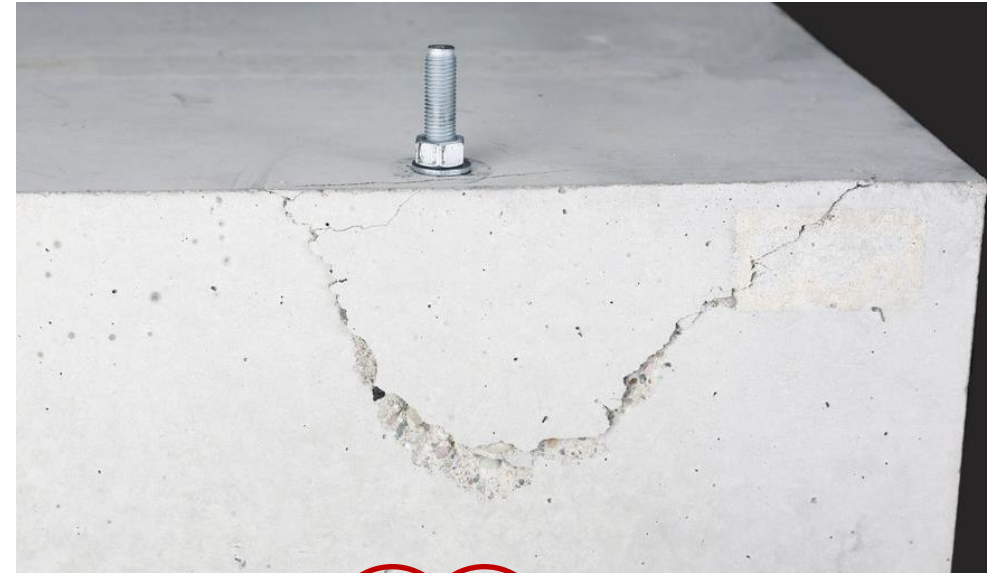
Ръбово разрушение при срязване
